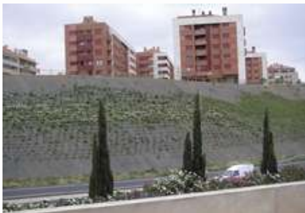
Instalación de HORSOL®
