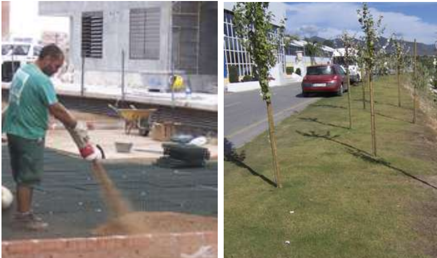
Instalación de PARKING VERDE
